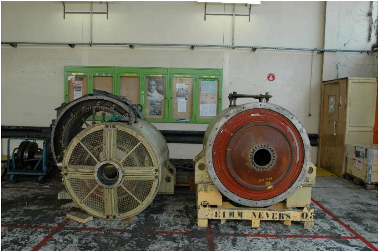
Vue intérieur de l'atelier de bobinage
