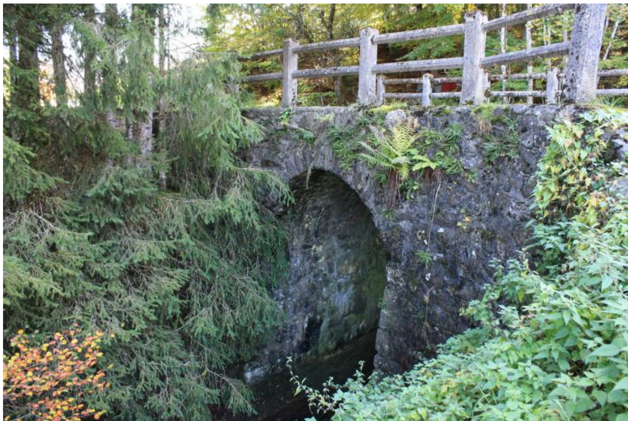
Pont de route de la Villaz, face aval
