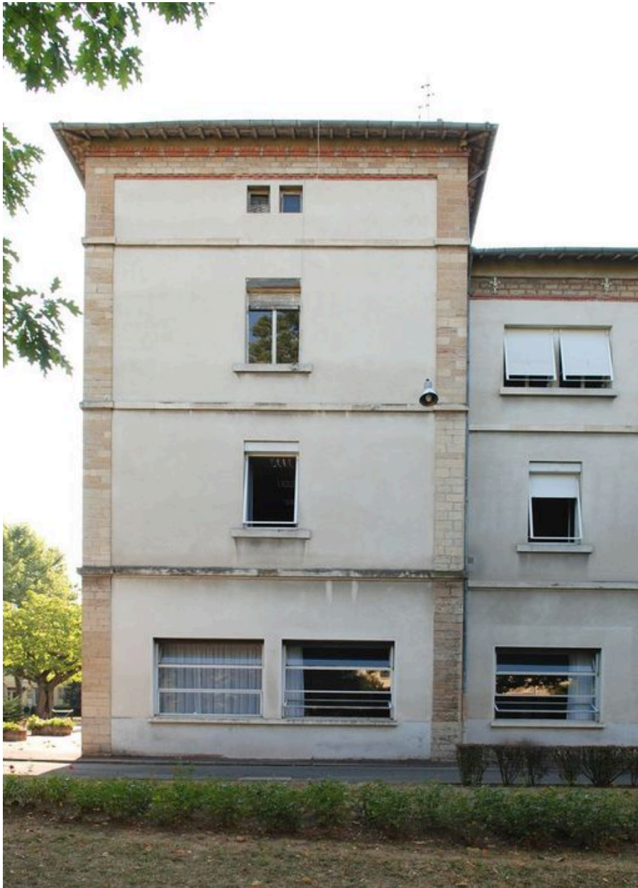
Façade ouest, détail de l'avant-corps latéral nord
