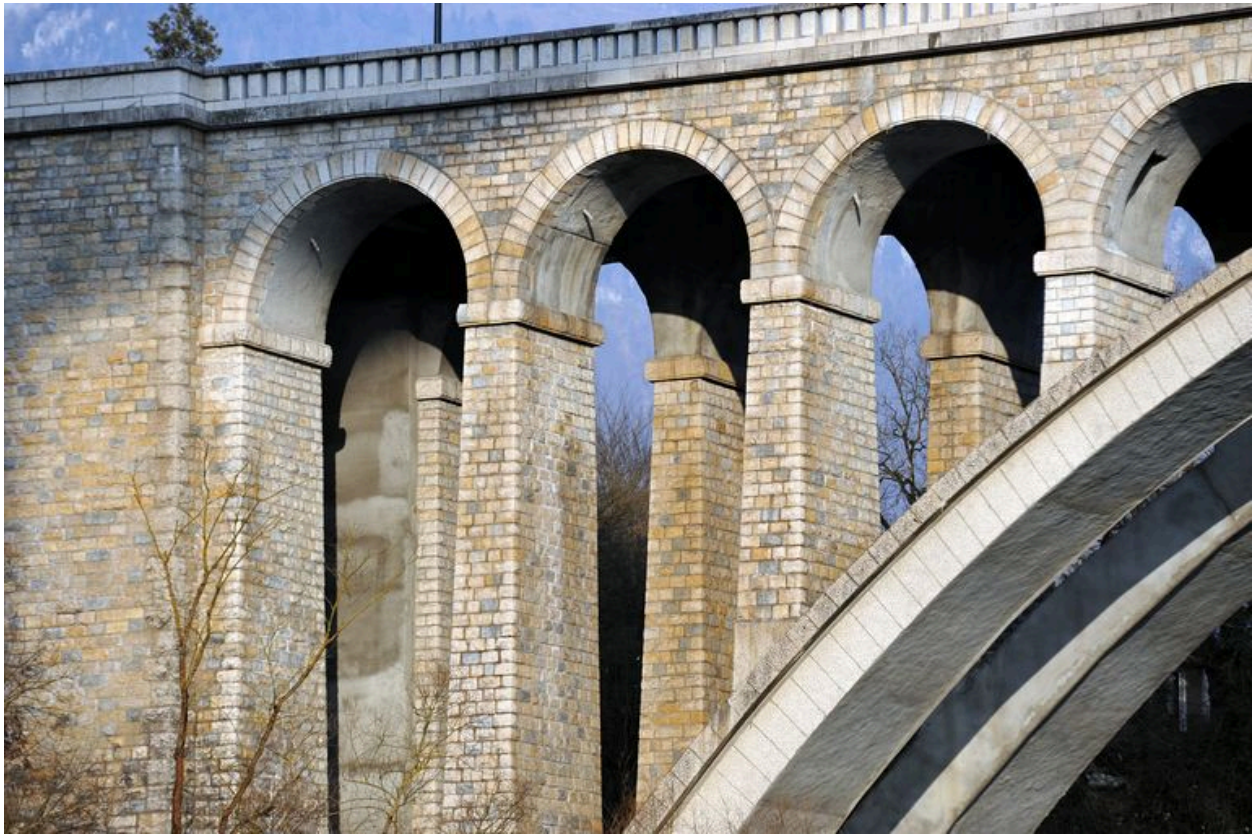
Partie droite de l'arche centrale, face aval, vue de détail : dédoublement des petites arches
