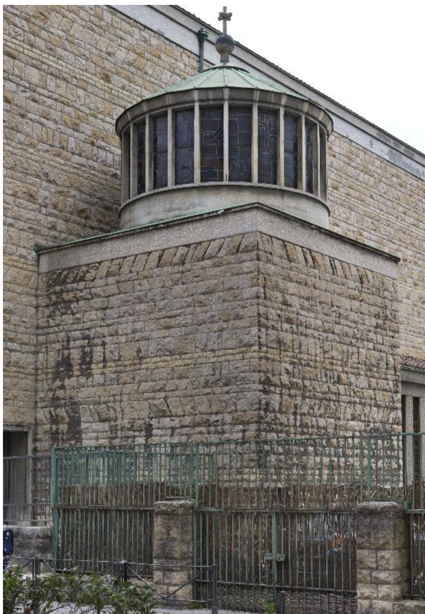
Vue partielle de la façade ouest : le baptistère
