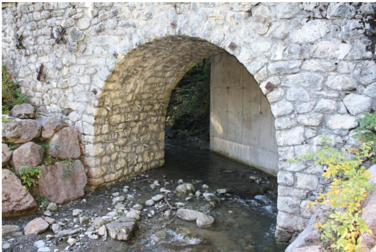
Pont de Dinn, détail cintre maçonné
