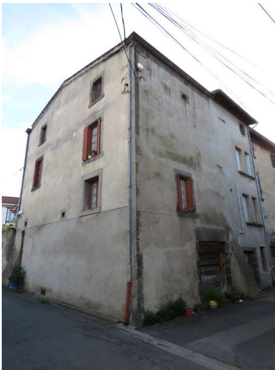
Vue générale : élévations arrière et latérale
