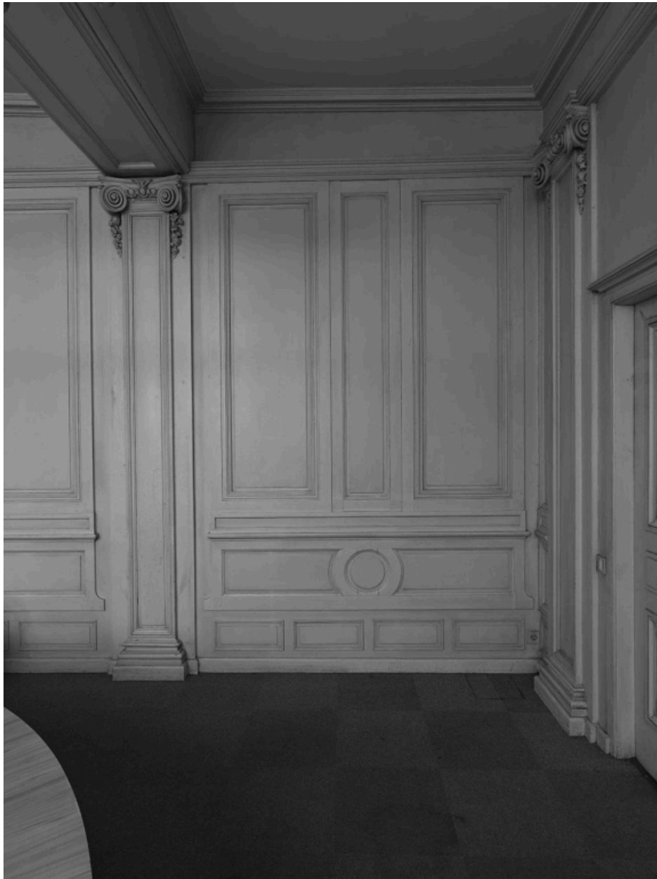
Bâtiment M. Rez-de-chaussée. Salle du Conseil. Détail d'un lambris de hauteur
