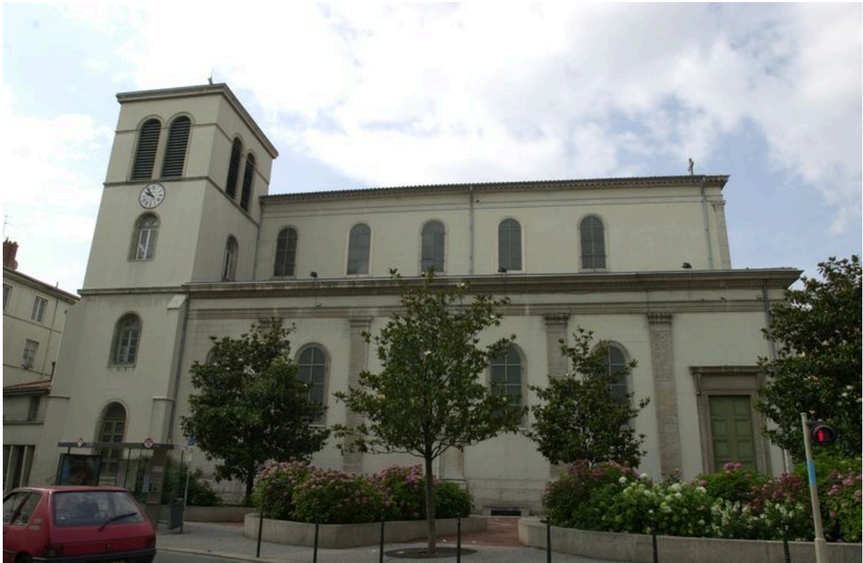
Vue de la façade latérale depuis la grande rue de la Guillotière
