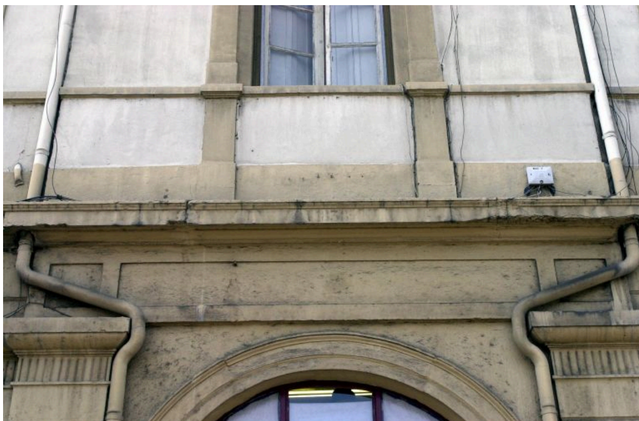
Détail de la date gravée sur le linteau du portail
