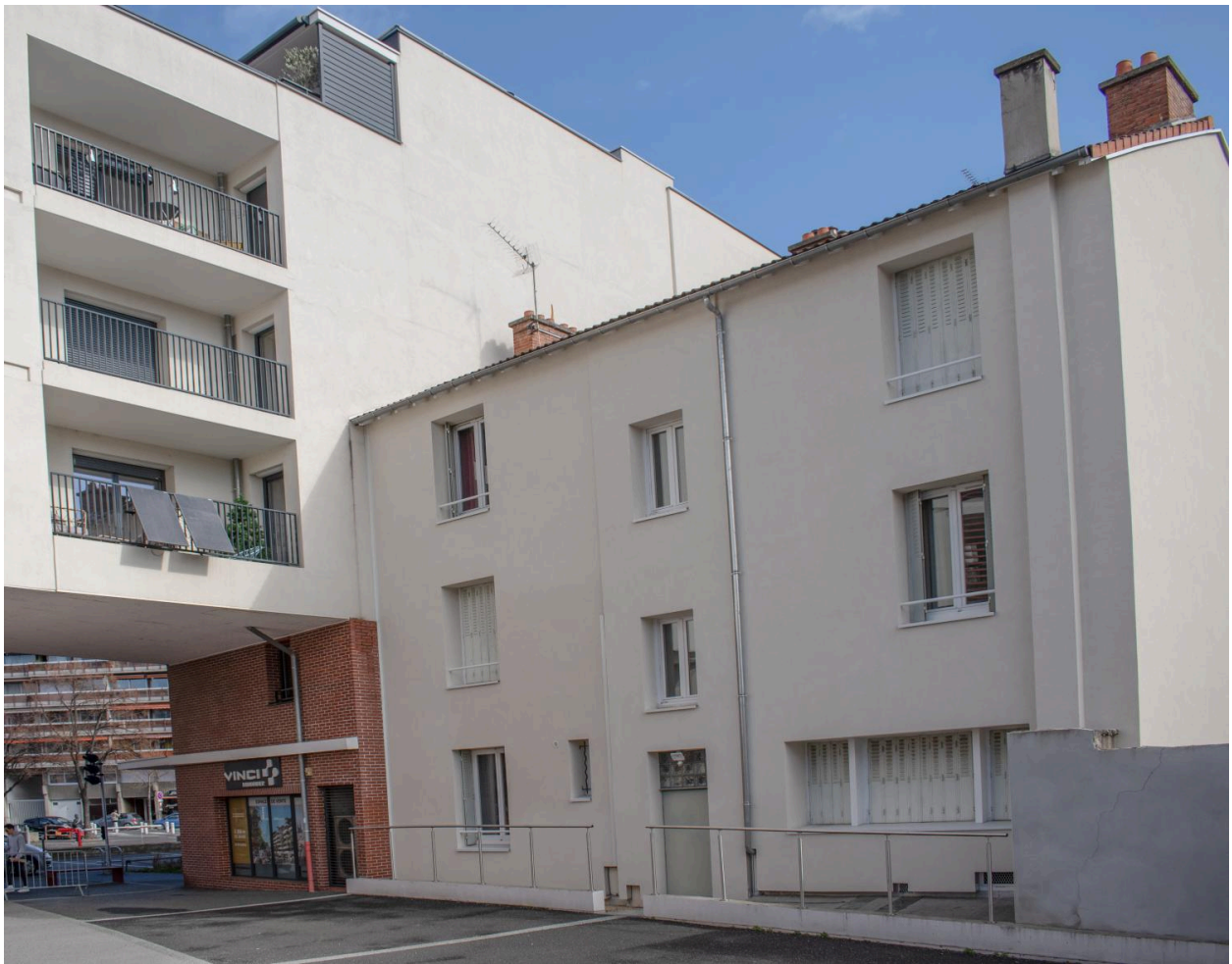
Façade sur la rue de Beaurepaire (aussi appelé chemin de Beaurepaire)
