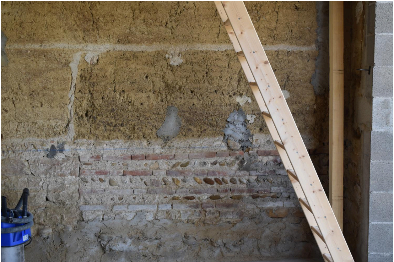
Détail de mise en œuvre du pisé - soubassement galets et briques
