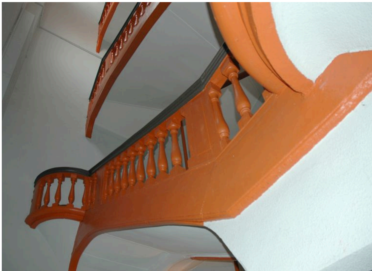
Vue partielle des paliers avec garde-corps à balustrade.
