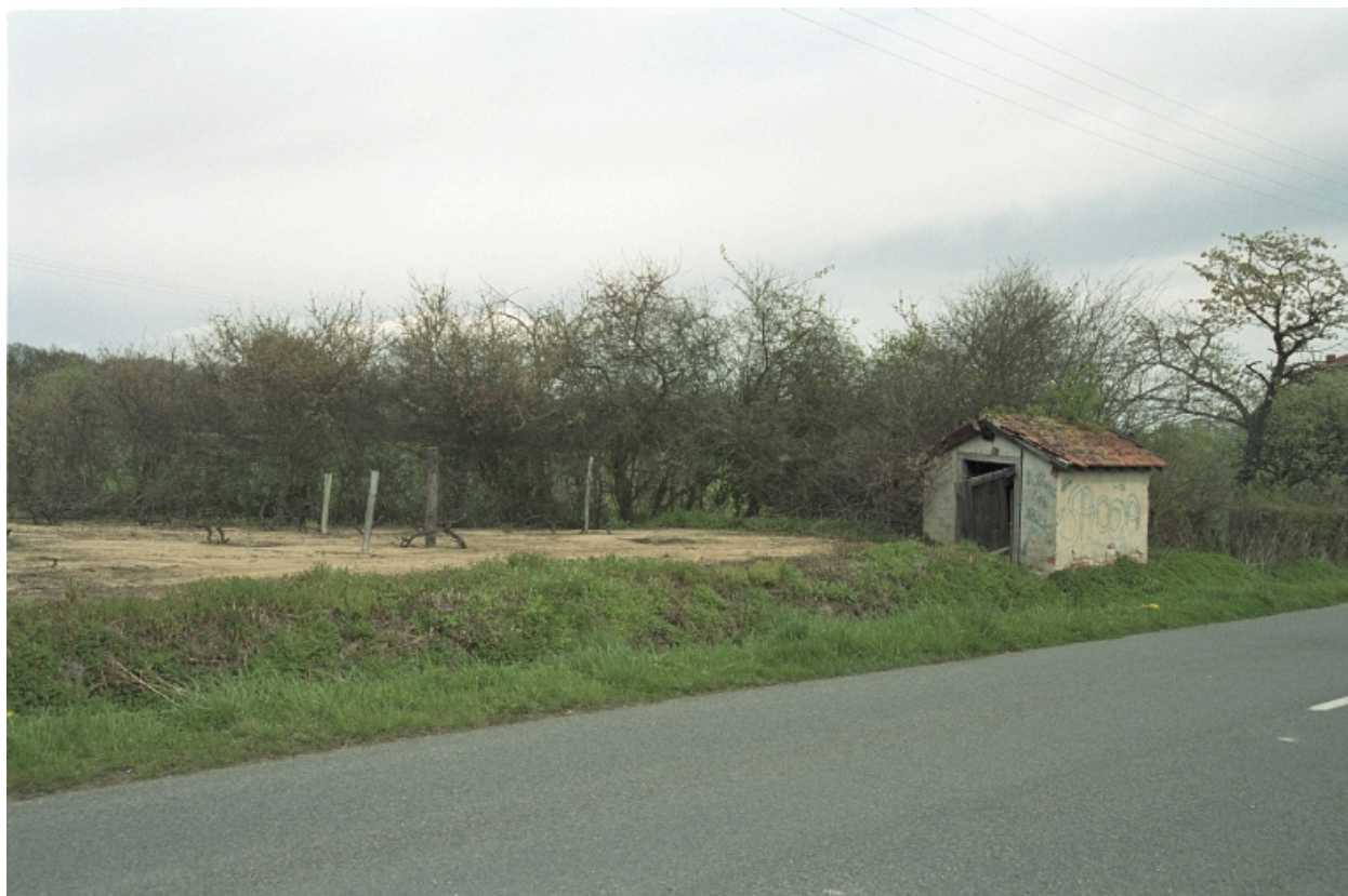
Arthun, La Garde (1987 A2 1187). Loge en rez-de-chaussée de type R1a1.
