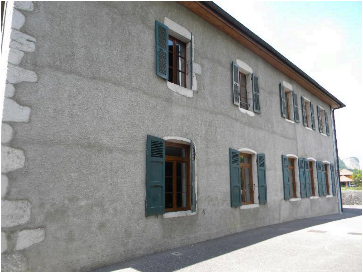
Vue de la façade est.
