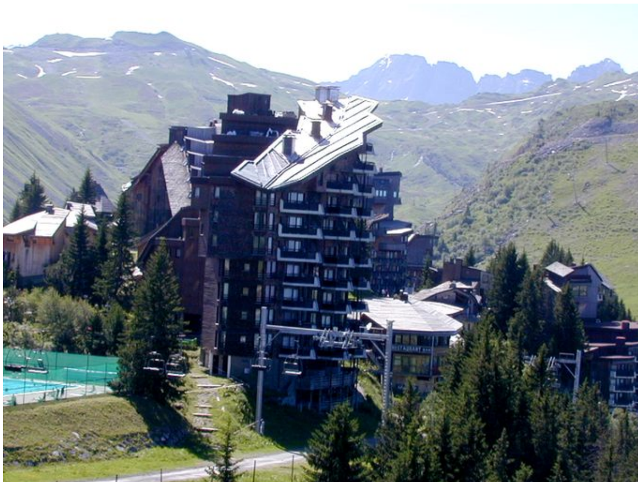
Vue générale depuis le nord-ouest
