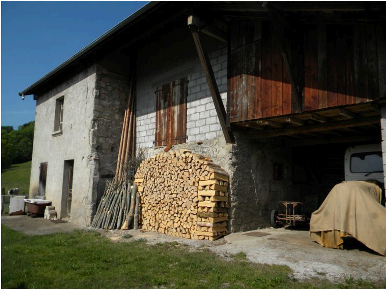
Une ferme de La Bauche.
