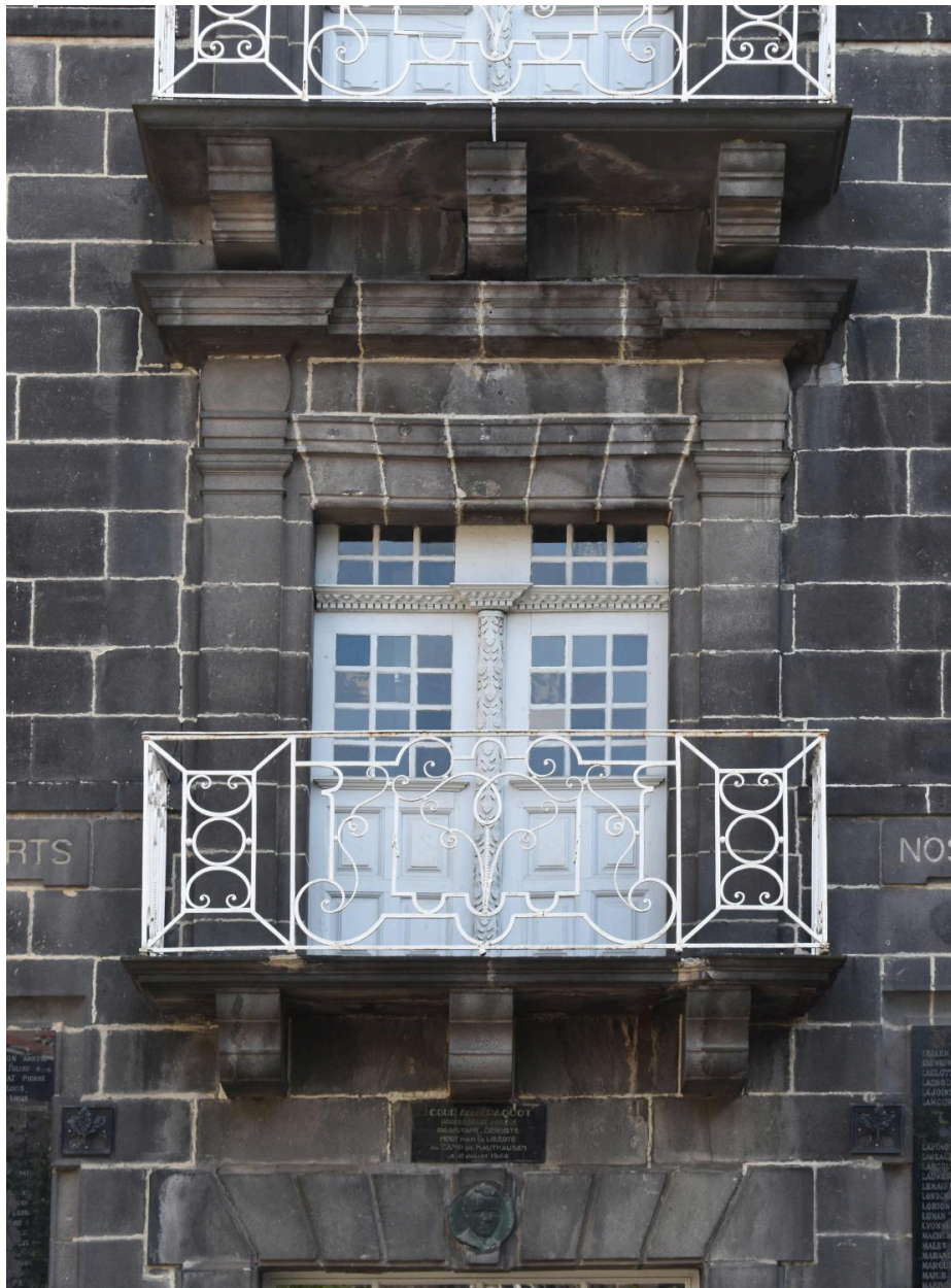
Pavillon central : détail de la fenêtre du 1er étage
