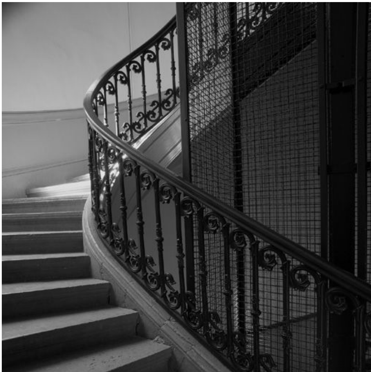
2e étage de l'escalier
