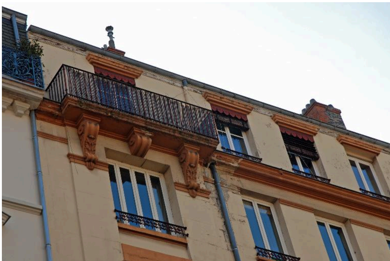
Vue rapprochée du couronnement
