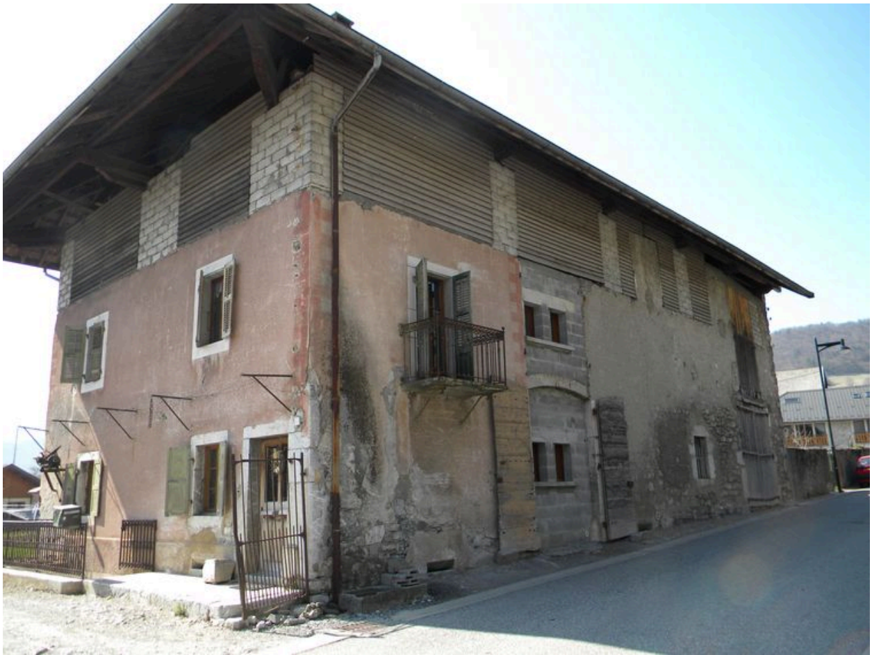
Vue d'ensemble d'une ancienne ferme aux façades peintes. (B7 1277).
