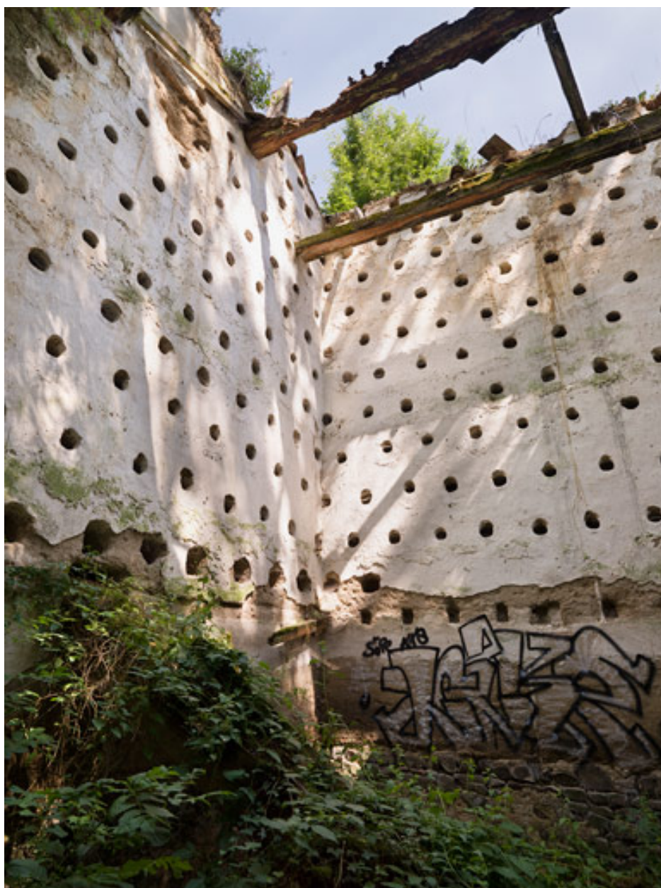
Vue intérieure : angle nord-ouest.
