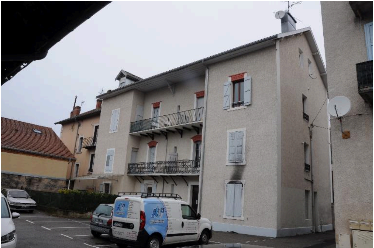
Vue depuis l'arrière
