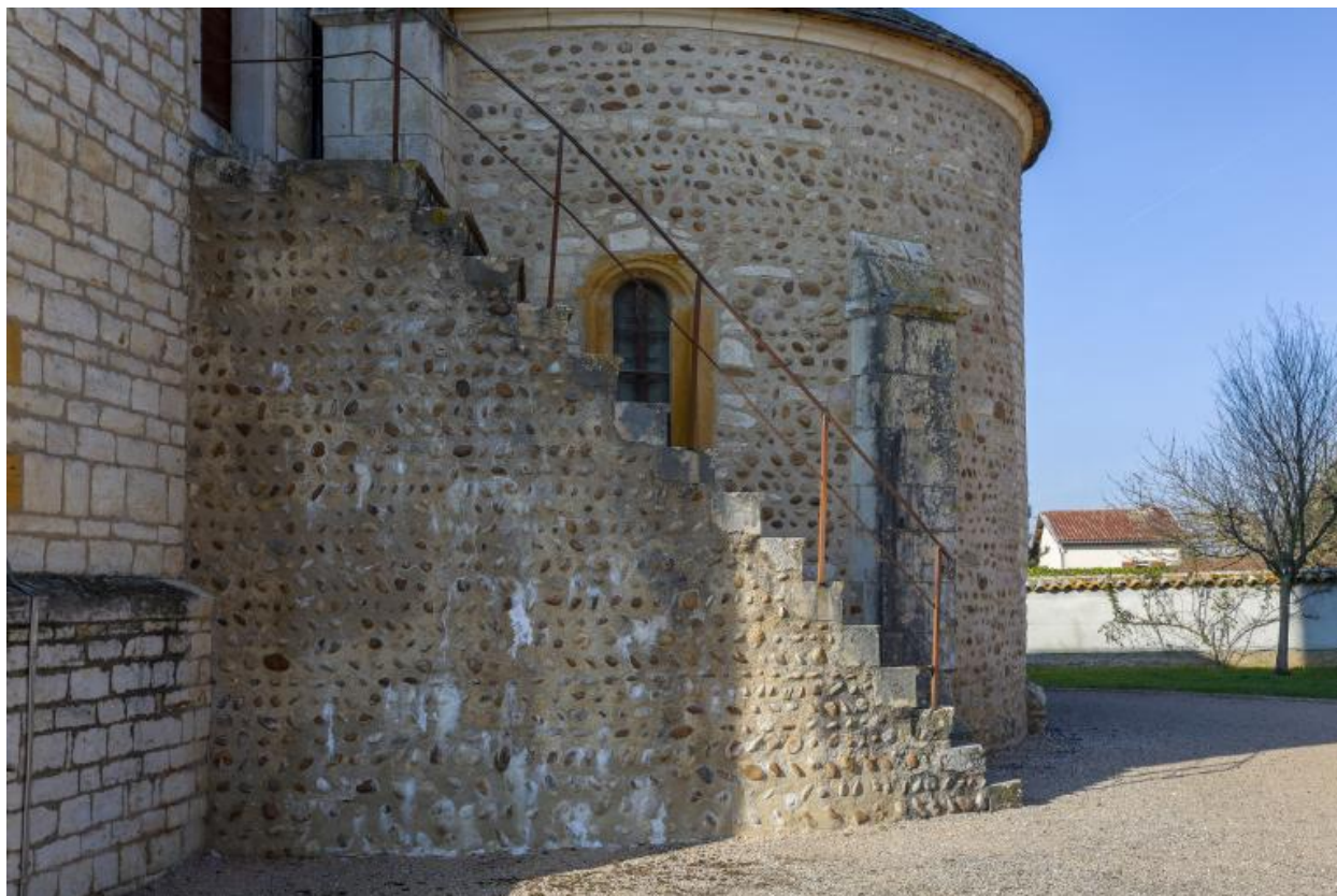
Chevet : abside, escalier menant au clocher.
