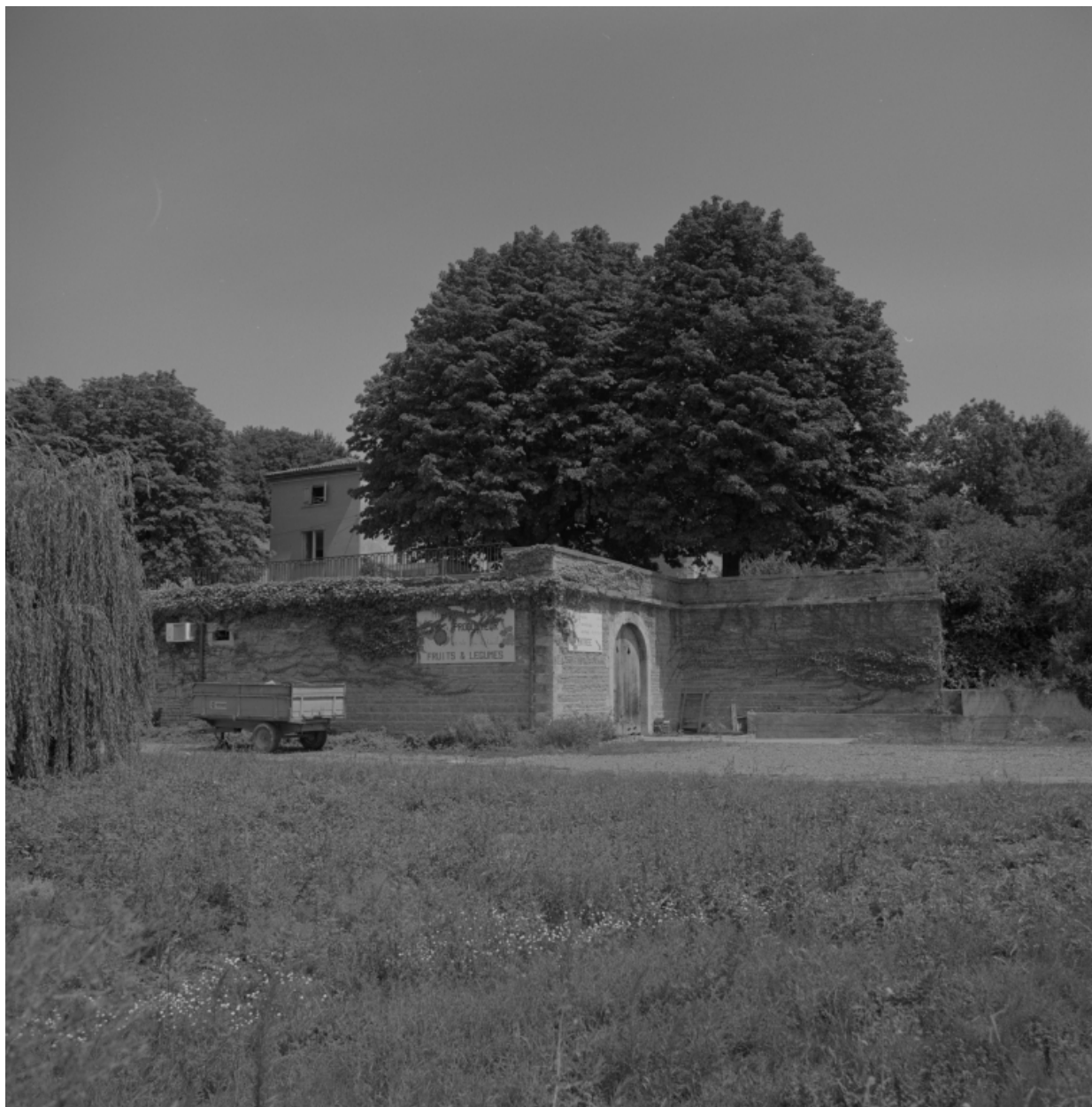
Vue d'ensemble depuis la route : ancienne orangerie formant terrasse.
