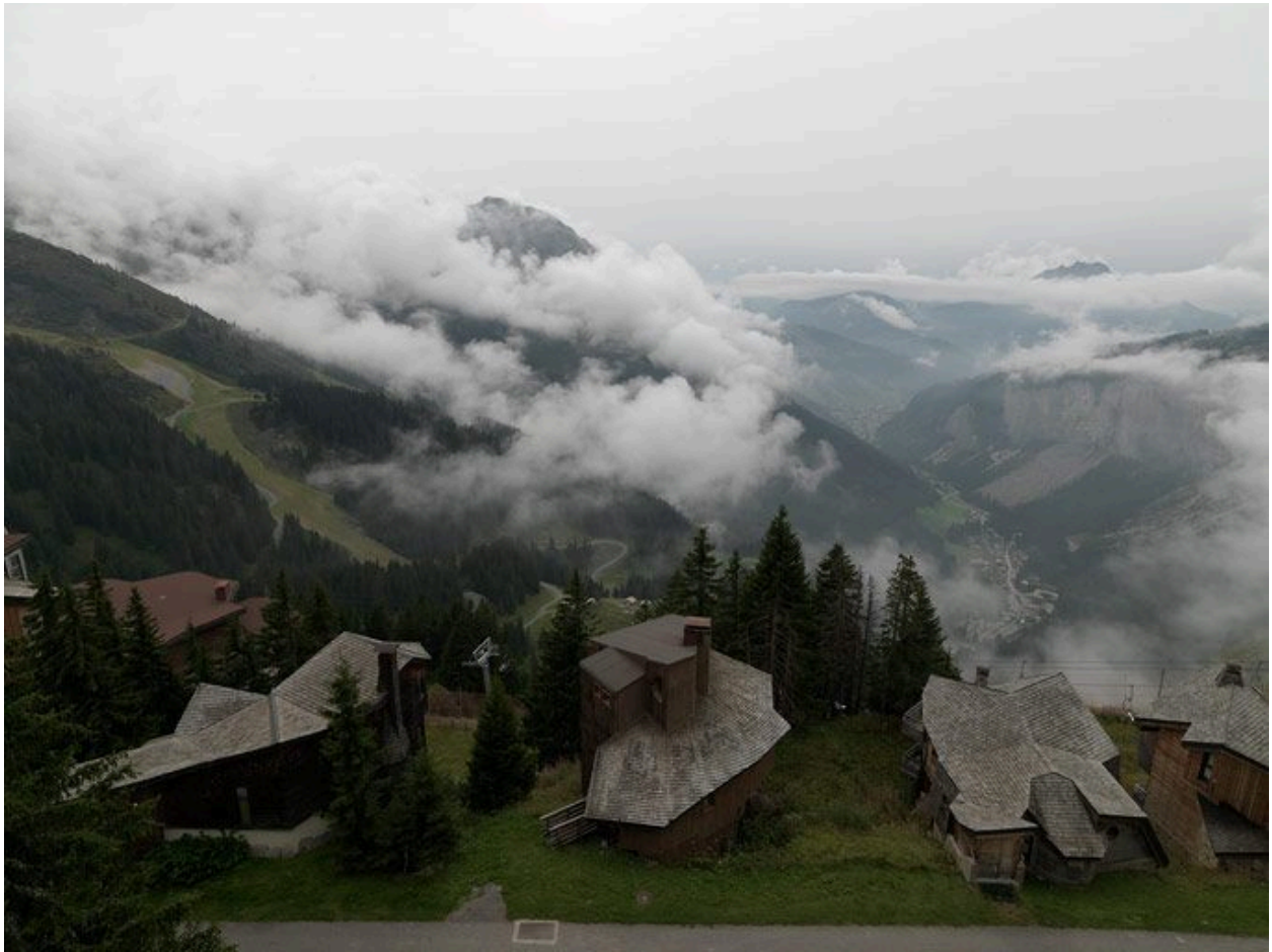
Les chalets nord-ouest. Vue d'ensemble des toitures
