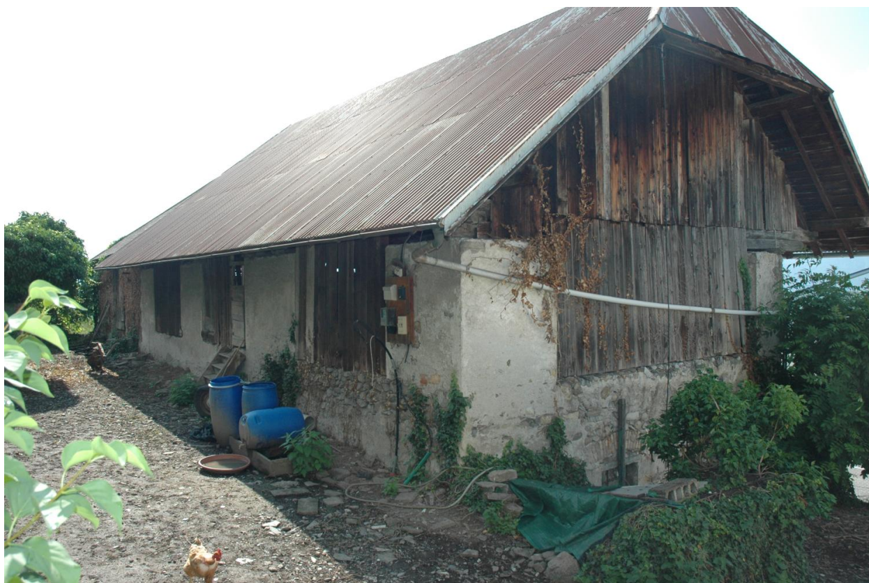
Grange-étable en périphérie (2018 B 282).
