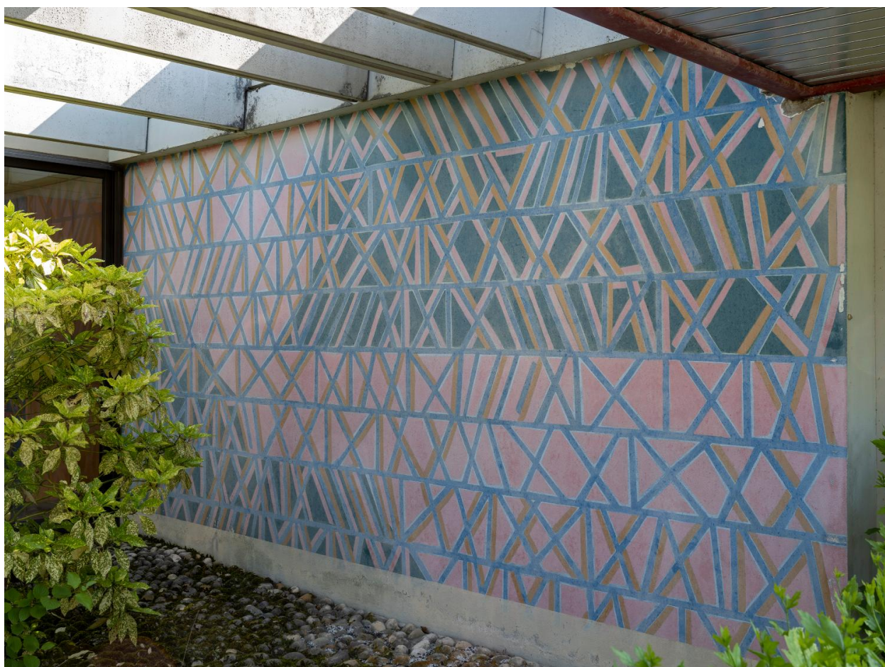
Vue d'ensemble côté extérieur
