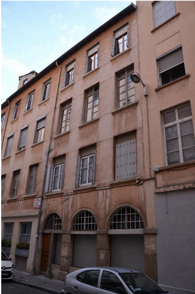
Vue d'ensemble façade ouest
