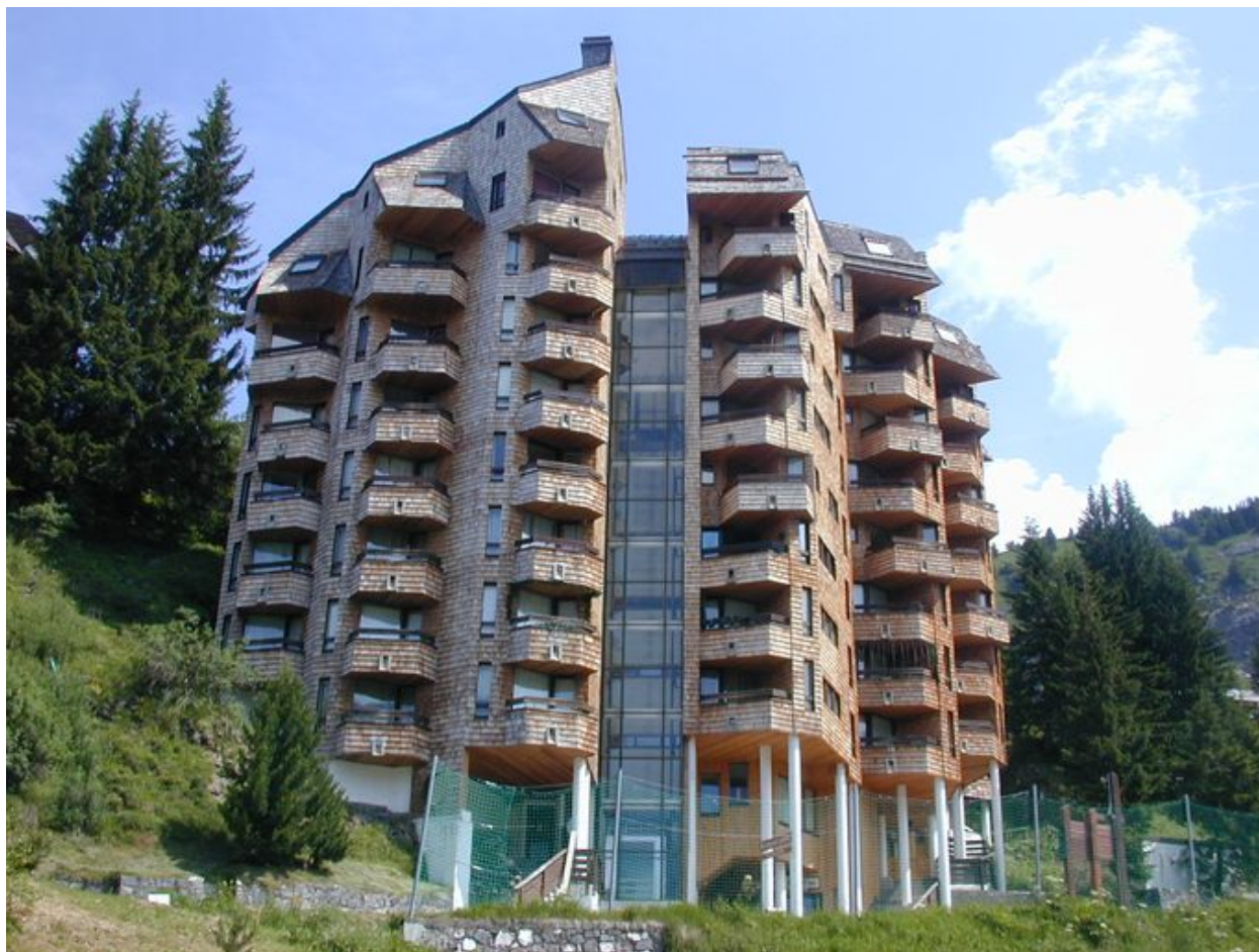
Vue d'ensemble de la façade sud
