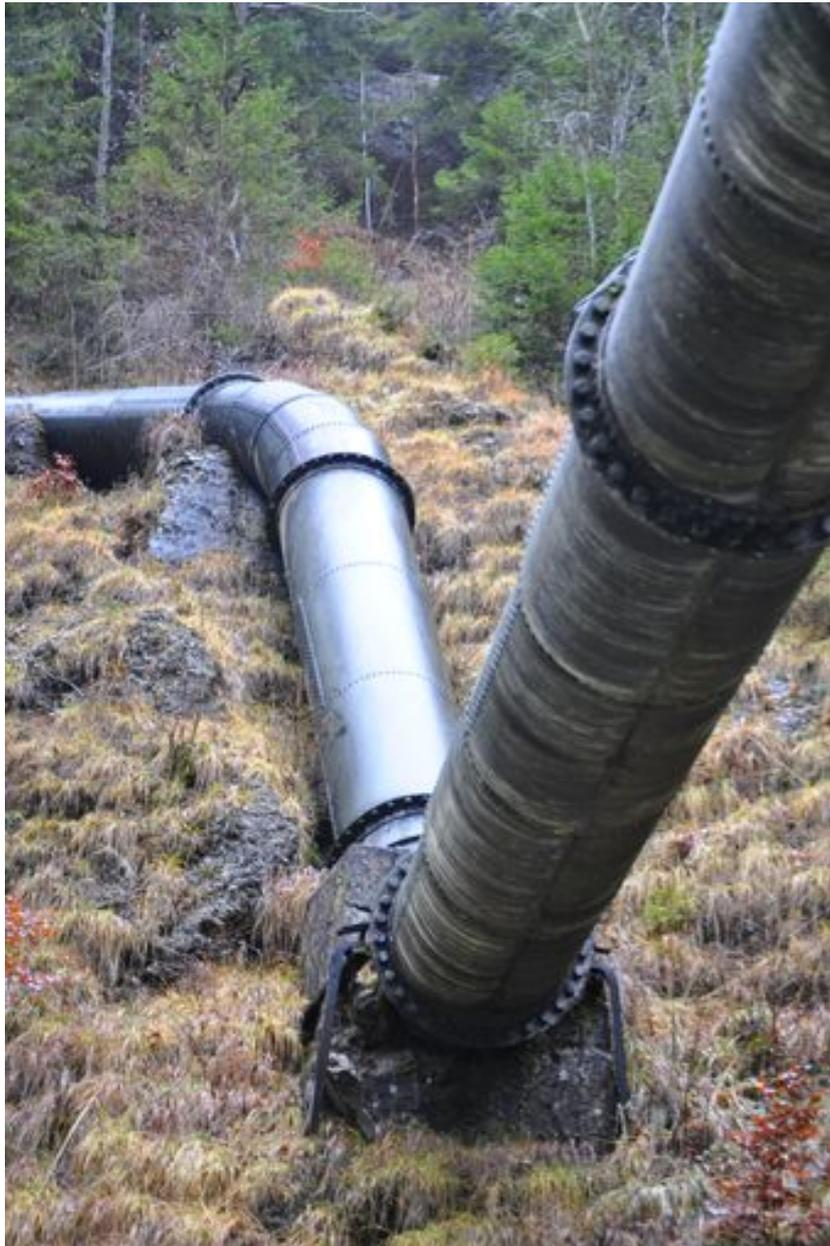
Détail de la conduite forcée en fer riveté
