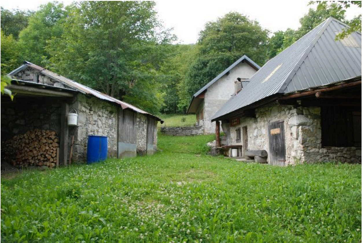
Vue de chalets (2016 G9 1026 et 1027) aux Chalets des Chausses, depuis l'est (non repérés).
