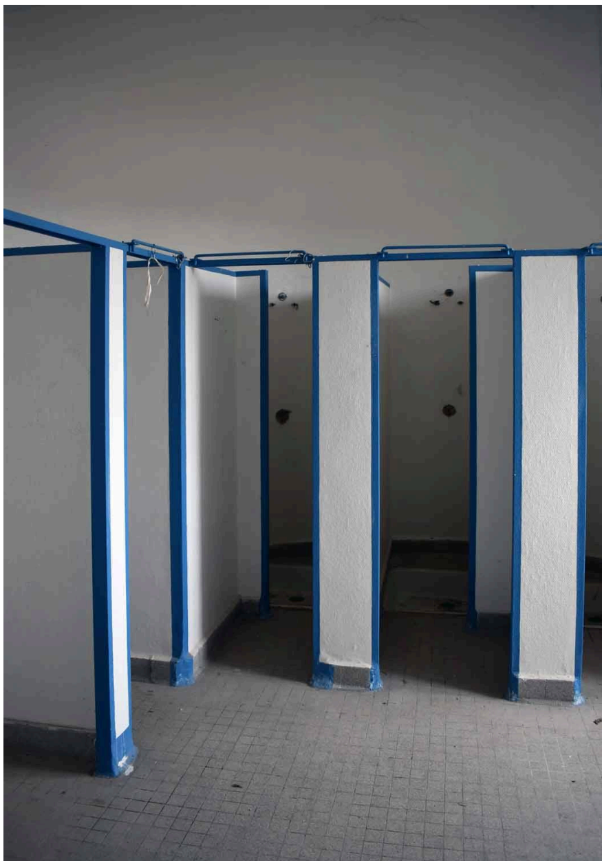
Château : anciennes cabines de douche, 1er étage, tour nord-est
