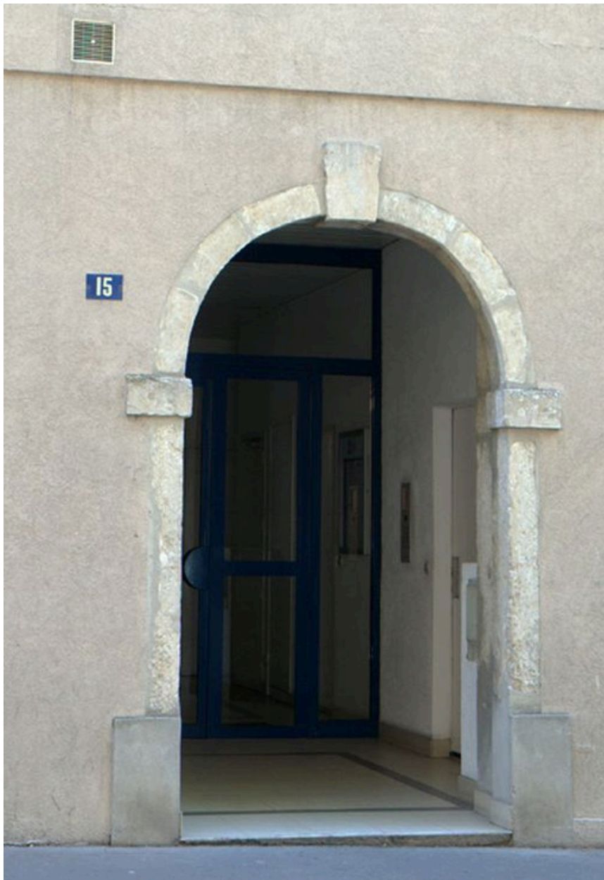
Porte en remploi, entrée 15 rue Claude-Veyron
