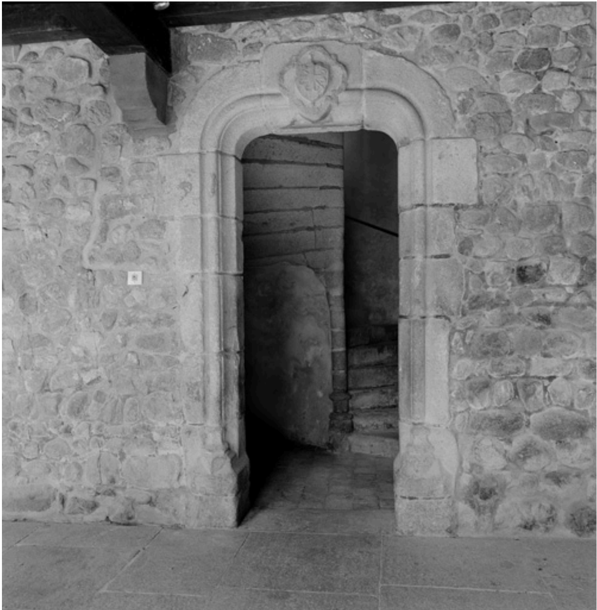
Détail de la porte de l'escalier en vis de l'aile nord.
