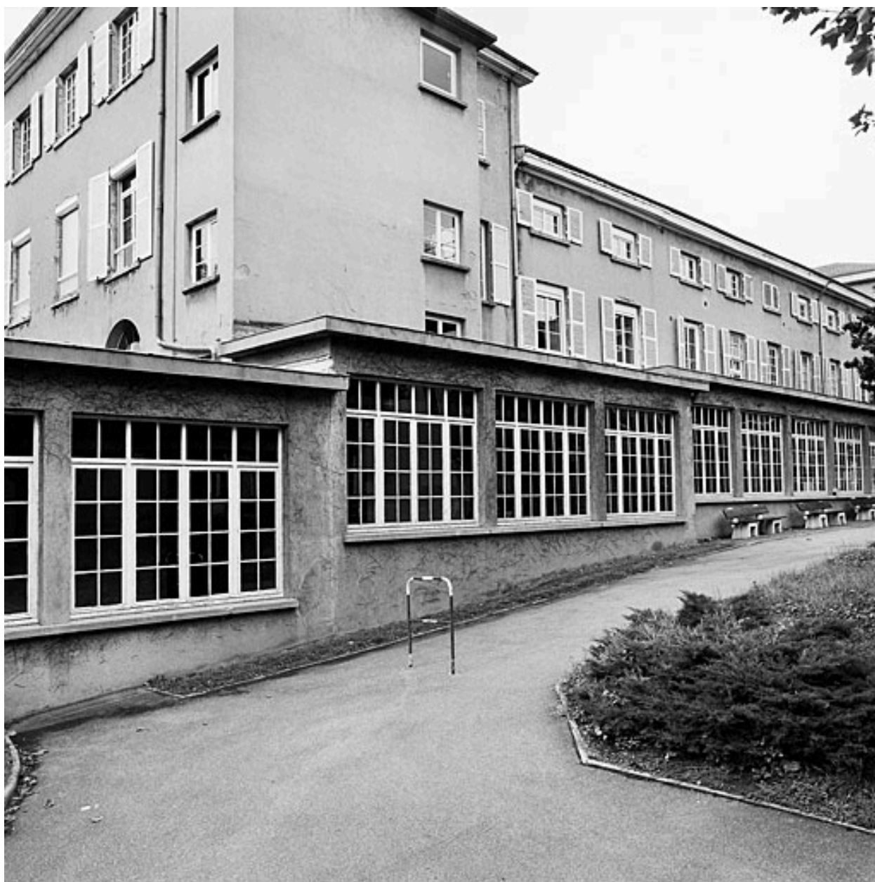
Vue d'ensemble sud des bâtiments
