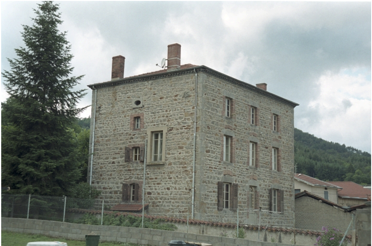
Maison de docteur puis d'André Durand, photographe, vue d'ensemble de trois-quarts depuis le jardin.
