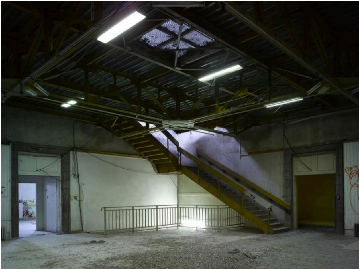
Escalier d'accès au dernier niveau, angle sud-est de la salle centrale.
