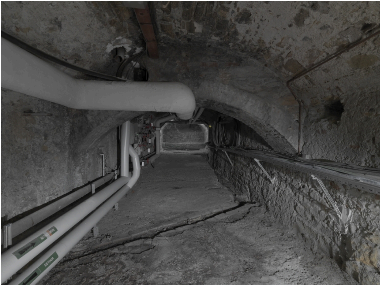
Cave du bâtiment O. Couloir est-ouest
