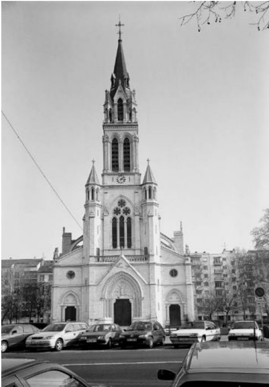
Vue générale de la façade principale
