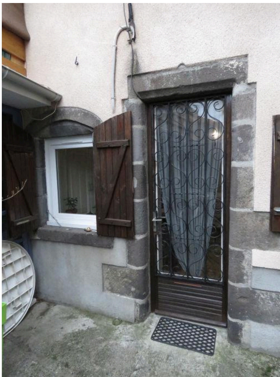
Vue de détail : porte d'entrée et baie couverte d'un linteau délardé en arc segmentaire
