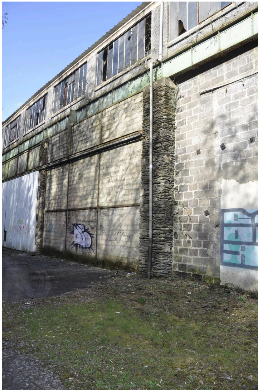
Détail matériaux de construction
