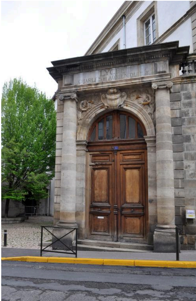
Ancienne porte d'entrée du lycée, rue du Général-Lafayette
