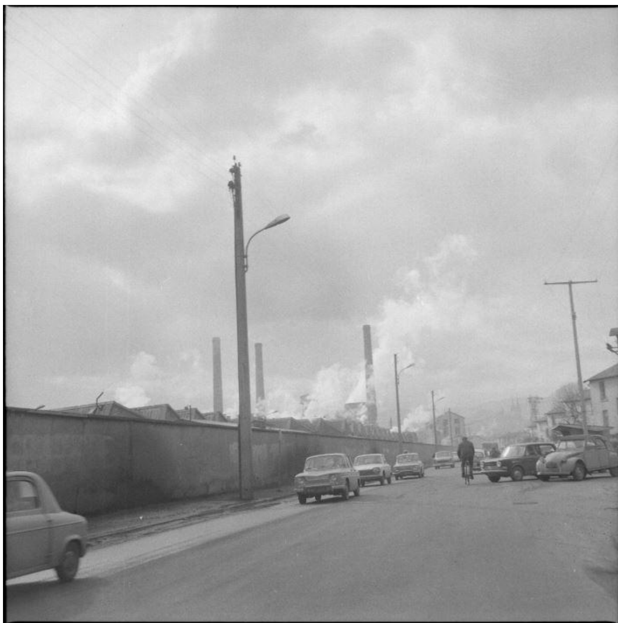
Les abords de l'usine depuis l'avenue Fernand-Forest, vers 1972.
