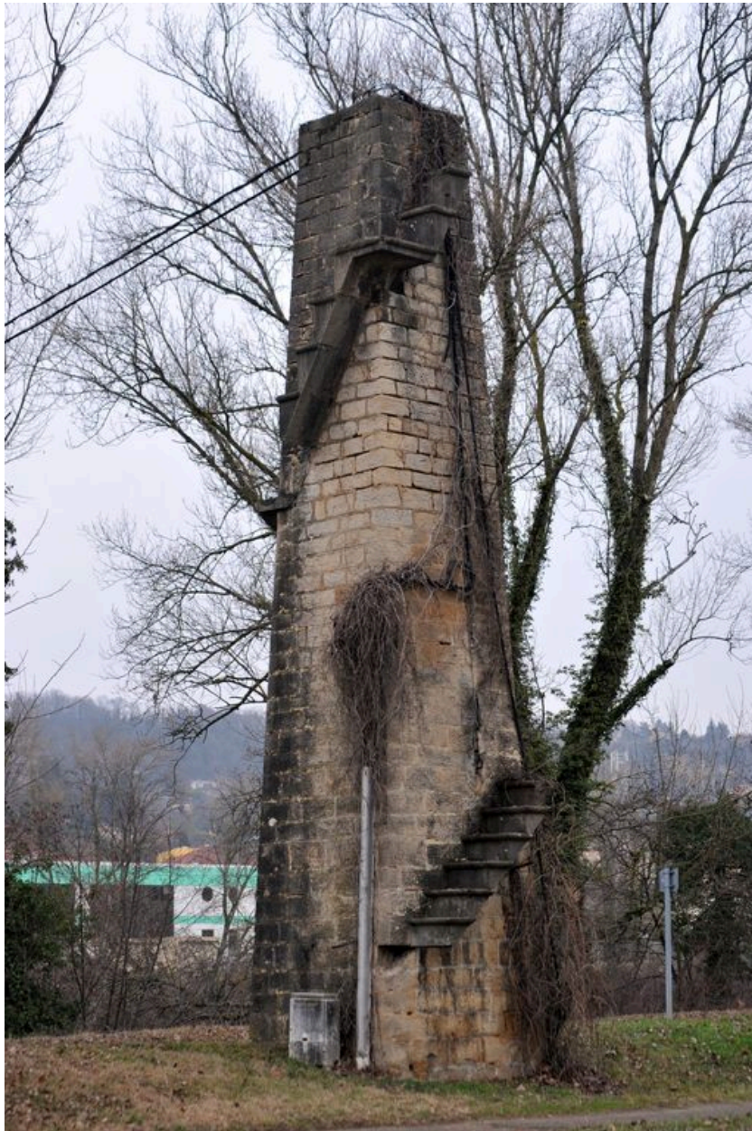
Pile gauche, angle sud, vue générale (depuis la rive gauche)
