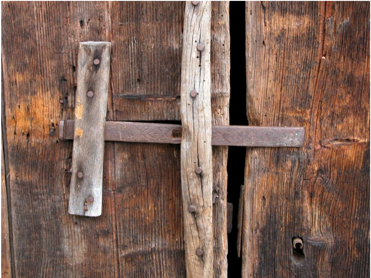
Détail de l'élément de fermeture de l'étable : verrou à pêne métallique gravé.
