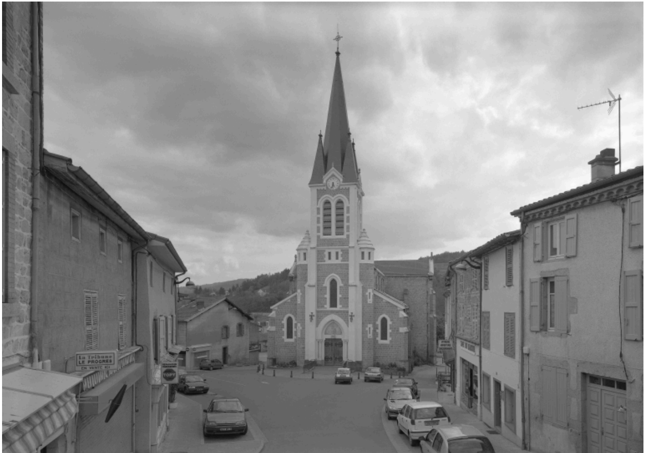
Vue générale depuis le nord.
