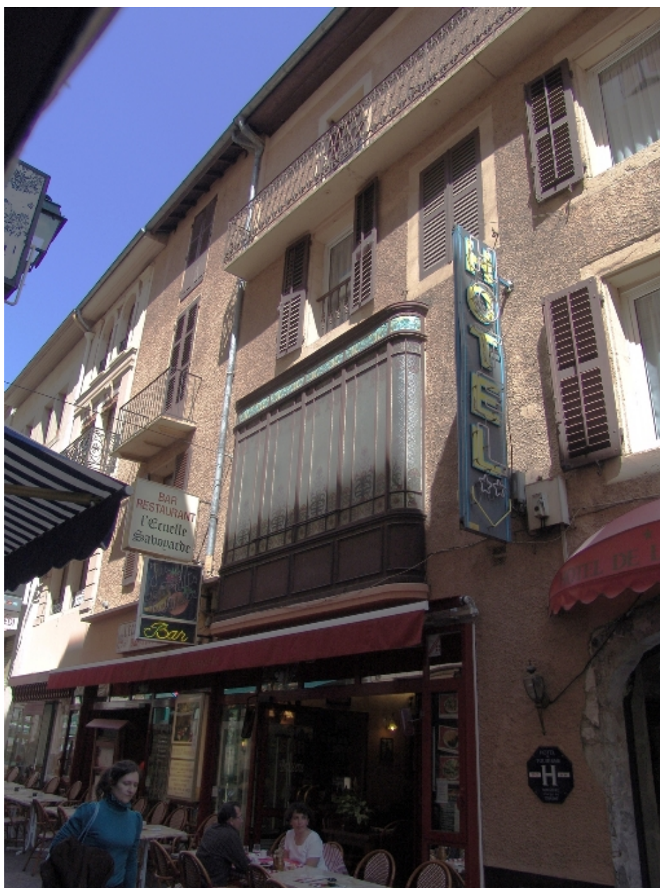
Façade sur la rue
