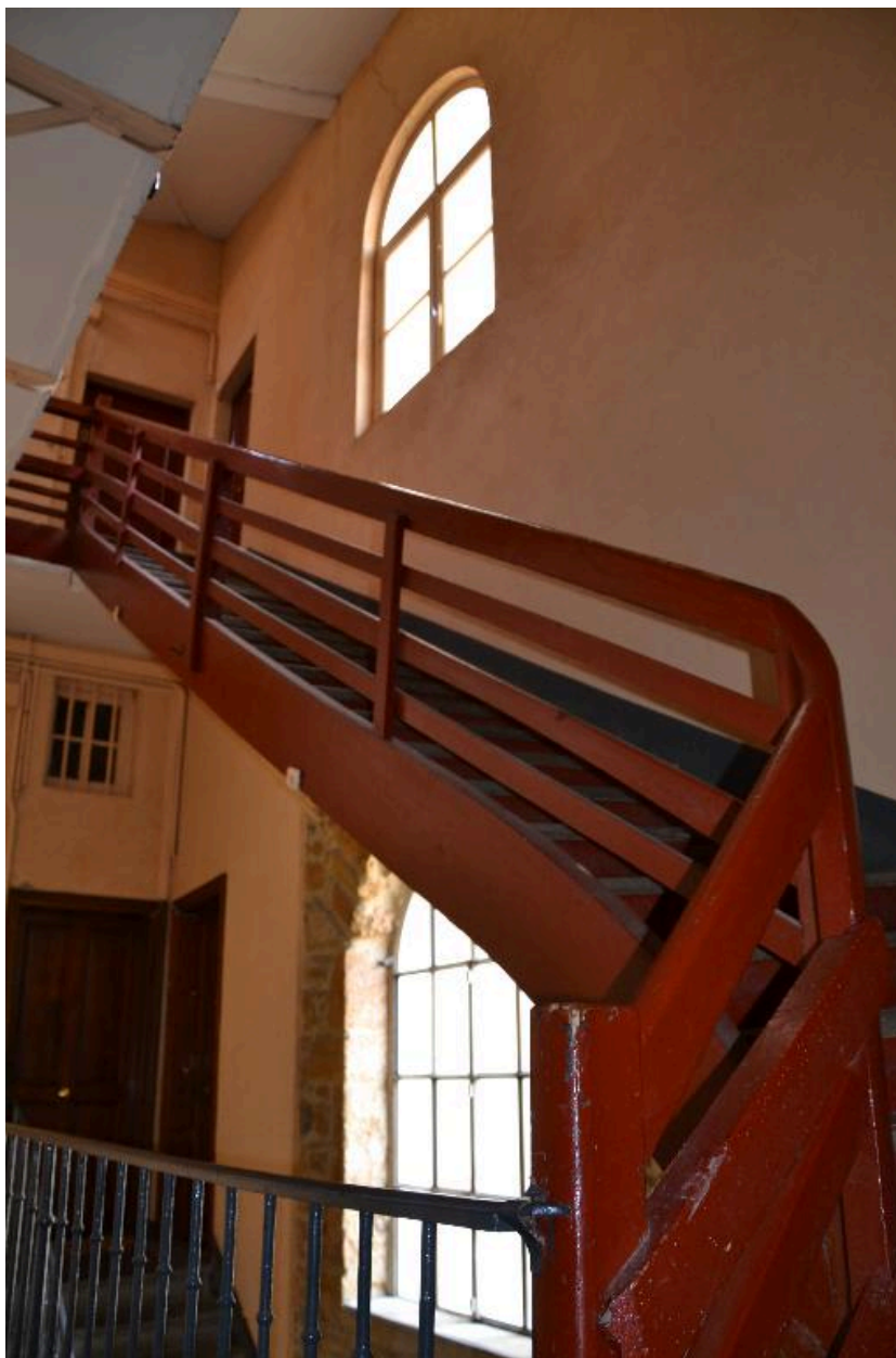
Escalier dernier niveau
