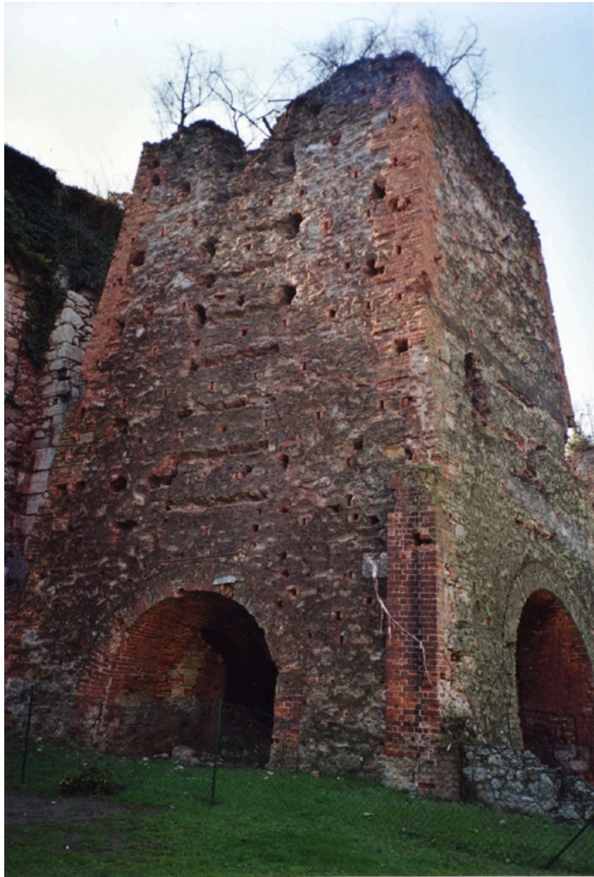
Vue sud du haut fourneau
